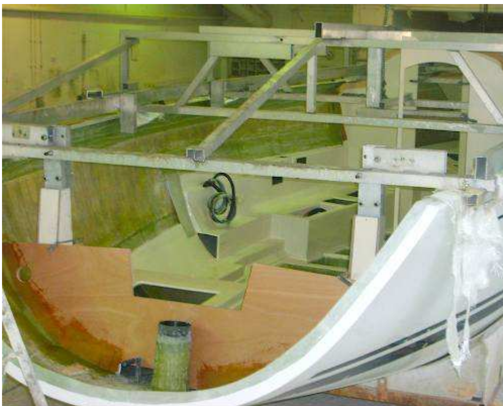
Montaż modułu i grodzi w kadłubie
